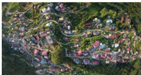
爱德基金会携手闲鱼发起“擦亮乡村”项目, 为乡村安装太阳能路灯, 既方便群众生产生活, 也通过绿色能源利用倡导绿色可持续乡村发展
